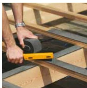
**NASTRO PROTEZIONE** per listoni sottostruzione: separa i listoni di sottostruzione dalle doghe da terrazza.
